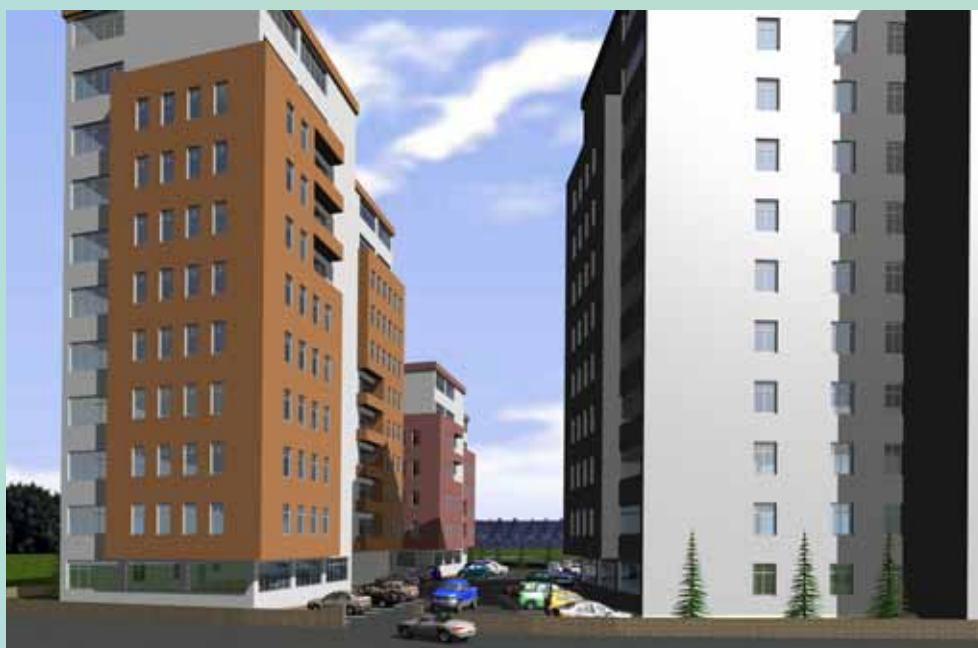
በቅርቡ ይጠናቀቃል ተብሎ የሚታሰበው የፌዴራል ዋና አዲተር መሥሪያ ቤት አዲሱ ህንጻ
