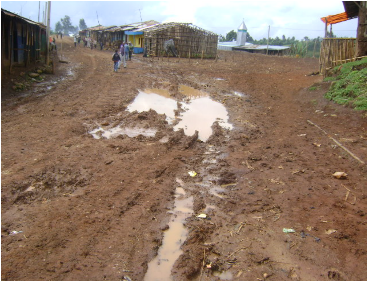
ፎቶ 4 በኦሮሚያ መንገዶች ኮንስትራክሽን ኢንተርፕራይዝ በ2003 በጀት ዓመት ደረጃውን ሳይጠብቅ የተጠገነ መንገድ( ከጅማ ሰንተማ)
