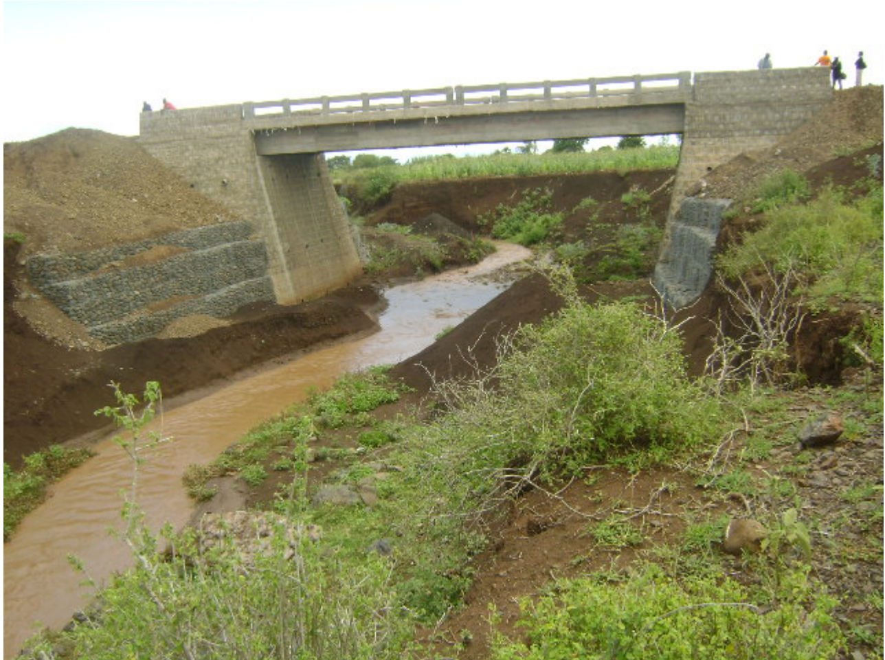
ፎቶ ግራፍ 3 የሰንደዴ ድልድይ ላይ የአፈር መሸርሸሩን ለመከላከል የተሰራውን ስራ የሚያሳይ
