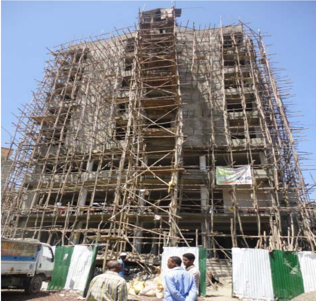
ፎቶ 4 ያለአማካሪ ተሳትፎ እየተገነባ ያለው በአዋሳ ከተማ የሚገኝ የግለሰብ ህንፃ (ሴንትራል ሆቴል)
