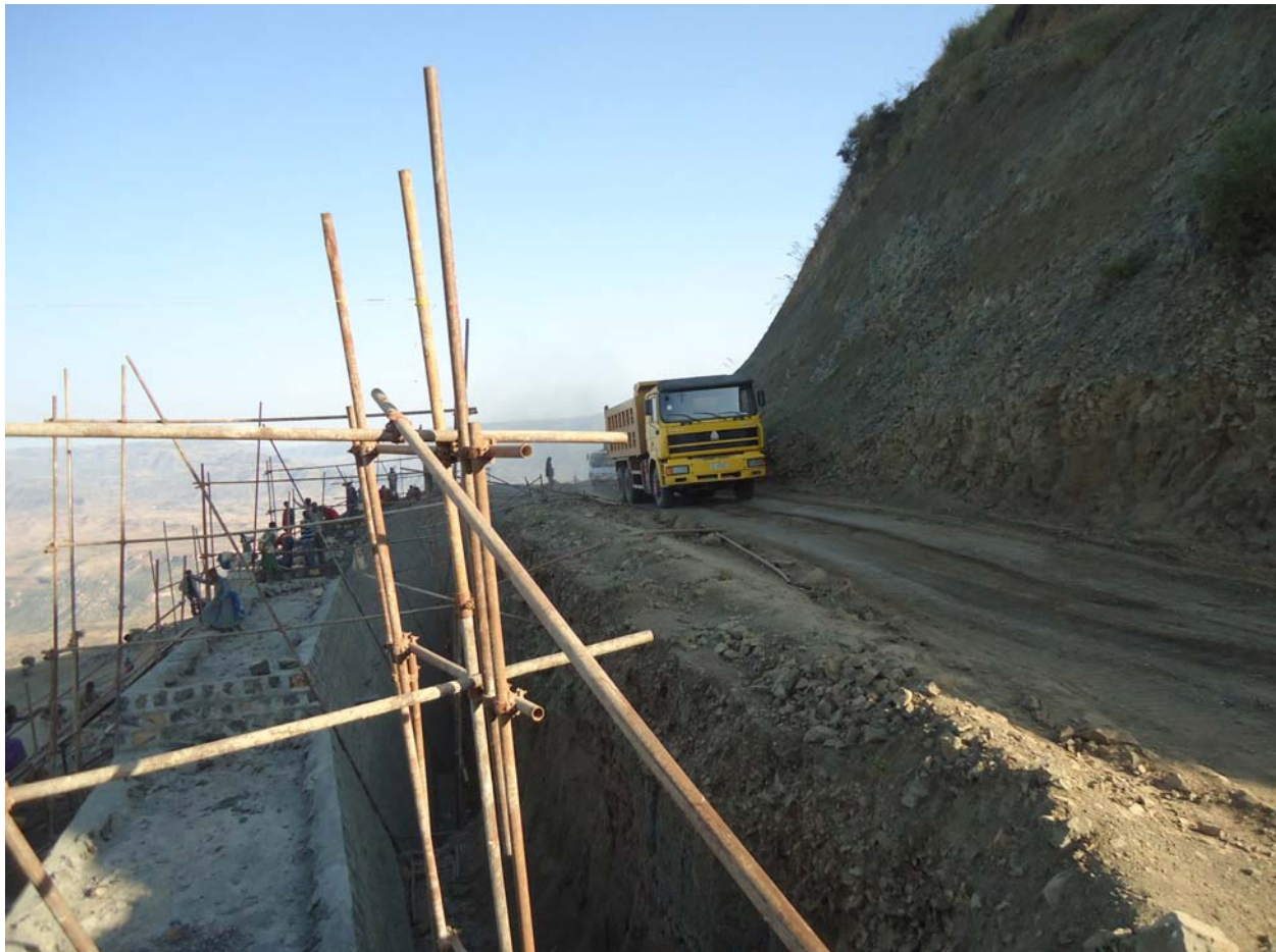
ፎቶ ቁ.2 የግንደወይን -መካነሰላም ፕሮጀክት መንገድ በሥራ ክንውን ላይ
