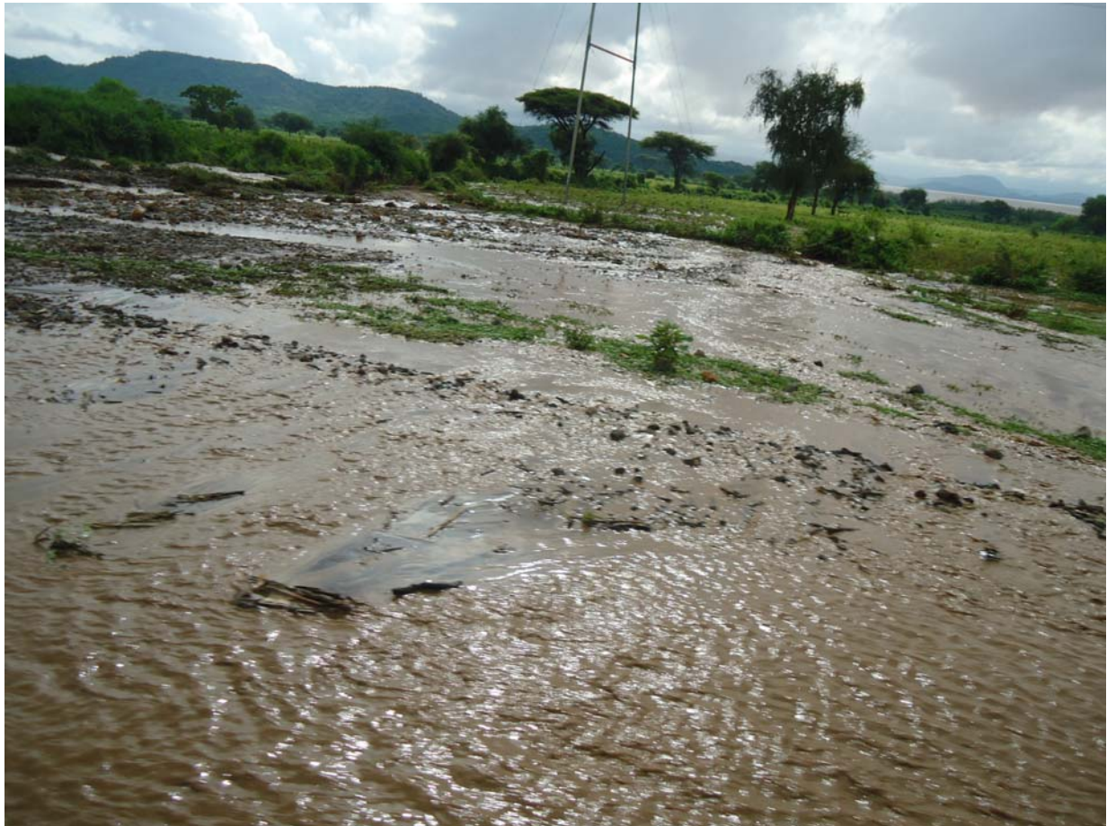
ፎቶ ቁ.1 ያልታሰበ ጎርፍ የደረሰበት የሁምቦ-አርባ ምንጭ ፕሮጀክት
