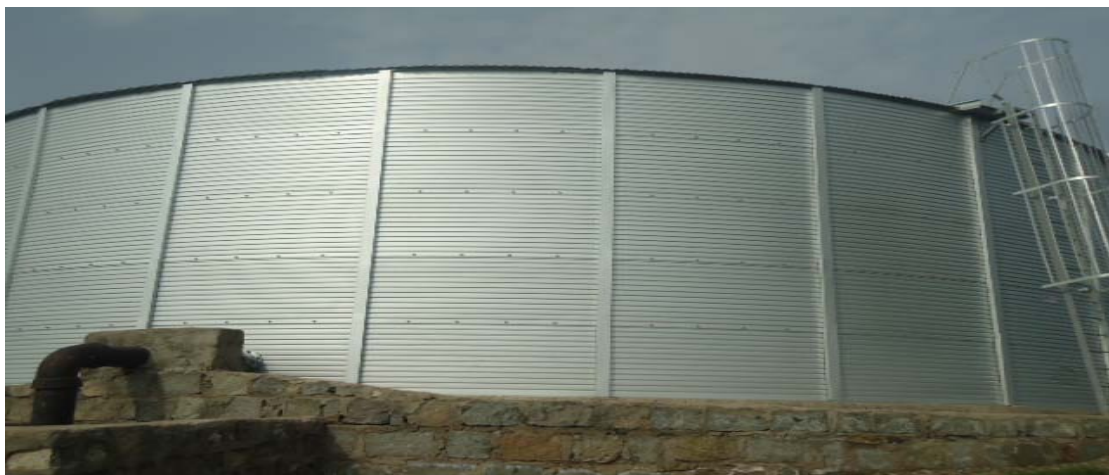
ፎቶ ግራፍ ቁጥር 2. ከላይ ለተገለጸው ፕሮጀክት የተሰራ 1,000,000 ሊትር ውሀ የሚይዝ የውሀ ታንክ
