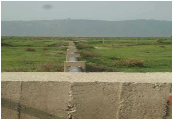
ፎቶ ግራፍ ቁጥር 1. ከላይ ለተገለፀው ፕሮጀክት ለ9.3 ኪ.ሎ ሜትር የተዘረጋ የግፊት መስመር ቧንቧ
