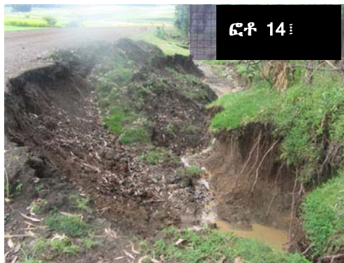
ፎቶ 14፤ በደብረ ማርቆስ ዲስትሪክት የመንገድ ዳር የፍላጎት ማስወገጃያ ቦታችን ከአግባቡ ባለመሠራታቸው እና እንክብካቤ ካና ጥገና ባለመደረጉ በአካባቢ ላይ አያደረሱ ያሉ ጉዳቶችን የሚያሳዩ ጠላቶች
