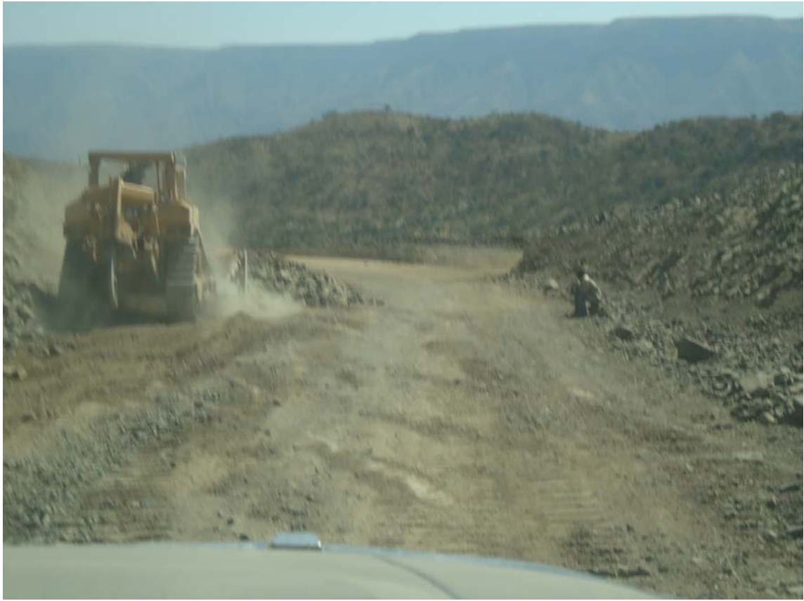
ፎቶ 2: ገና በመሠራት ላይ ያለ የእንዳቶ ጋሰራ መንገድ ሥራ ፕሮጀክት የሚያሳይ ፎቶ
