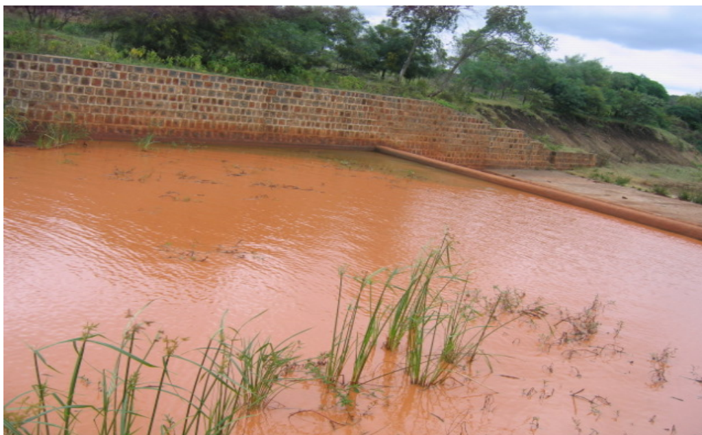
ፎቶ 10: በቦረና ዞን ቡሌ ሆራ ወረዳ ሞቶቆማ ሐራ ቀበሌ በተገነባ የከብቶች የመጠጥ ውሃ ግድብ የንፅሕና ክትትል ባለመደረጉ አላስፈላጊ አረሞች በቅለውበት የሚያሳይ ፎቶ።
