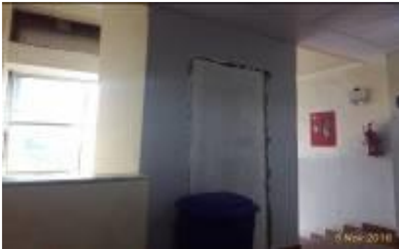
በአዲስ አበባ ባለ ስድስት ፎቅ ህንጻ ሊፍቱ ሳይገጠም ቋሚ የመጠቀሚያ ህንጻ የተሰጠው
