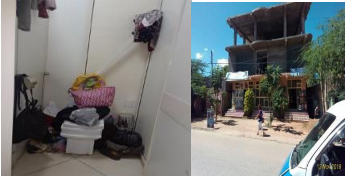
በአዲስ አበባና በድሬዳዋ አካል ጉዳተኞችን ያላማከለ መጸዳጃ ቤት እና ተዳፋት(Ramp) የሌላቸው ሕንጻዎች
