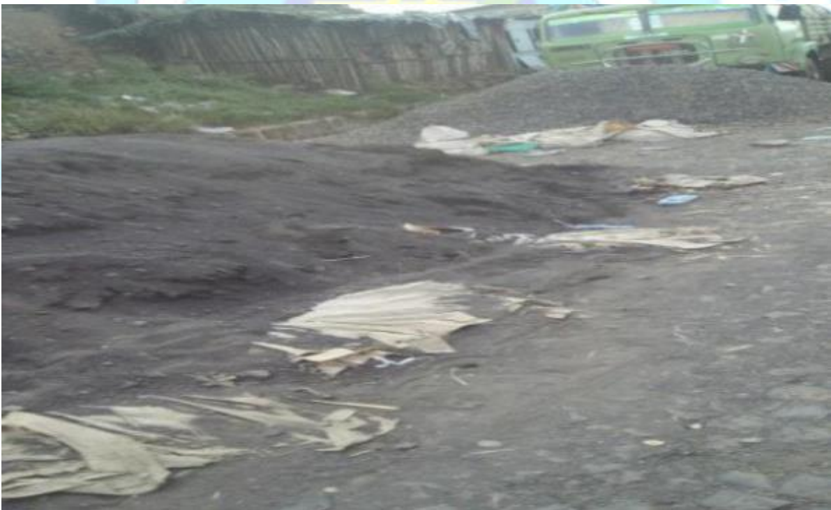
ስዕል ሰባት፡ በደብረ ታቦር የኮብል ስቶን መንገድ በግንባታ ቁሳቁሶች መዘጋት
