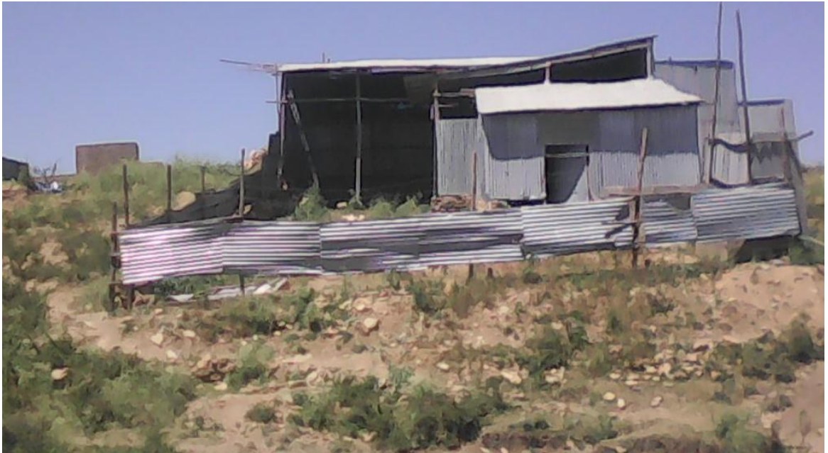
Figure 3:-ተክሊትና ዘምካኤል ብሎኬት አምራች ሕ/ስ/ማህበር፤ ሙልጌታና ተስፋይ ከብት ማደለብ ሕ/ስ/ማህበር በደደቢት ማይክሮ ፋይናንስ ኩሳ ቅርንጫፍ በመሰረተ ልማት ችግር ምክንያት ስራ ያቋረጡ ኢንትርፕራይዞች
