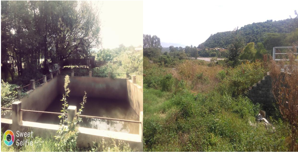
በባህርዳር የሚገኘው የሀበሻ ቆዳ ፋብሪካ አንደኛ ደረጃ የፍላሽ ማጣሪያ ፎቶግራፍ
