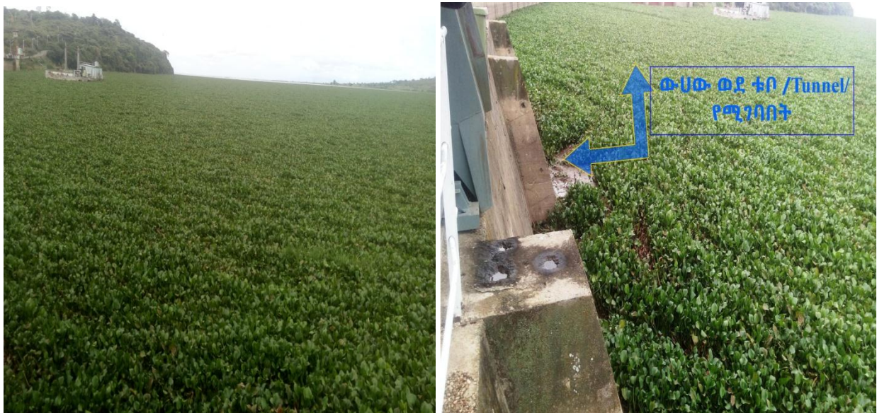
ምስል፡-17 የእንቦጭ አረም በቆቃ ሀይል ማመንጫ በኩል ያለበት ሁኔታ እና ውሀው ወደ ቱቦ /Tunnel/ የሚገባበትን ቦታ ዘግቶት
