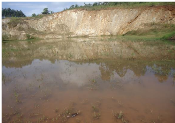
በጅማ-ቦንጋ ግብዓት የወጣበት ጉድጓድ የቦታ ጉድጓድ የቦታ መለያ.ቁ 4600 (ቦሮው)
