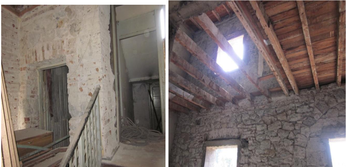
ፎቶ 5 በዕድሳት ላይ የሚገኘው የመማሪያ ክፍል ኮርኒሴ ተገነጣጥሎ የሚያሳይ
