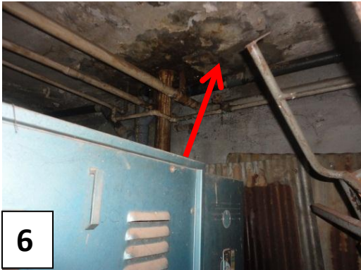
ምስል 6 የሽንት ቤት ፍላጎት ግርግዳ ሲያበላሽ (ተፈጥሮ ሳይንስ ኮሌጅ)ምስል7 ፍላጎት ቆሻሻዎች ከዋናው መስመር ጋር ሳይገናኙ ሜዳ ላይ ይፈሳሉ(የኢትዮጵያ አርክቴክቸርና ከተማ ልማት ኢንስቲትዩት)
