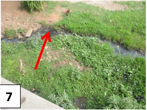
ምስል 6 የሽንት ቤት ፍላጎት ግርግዳ ሲያበላሽ (ተፈጥሮ ሳይንስ ኮሌጅ)ምስል7 ፍላጎት ቆሻሻዎች ከዋናው መስመር ጋር ሳይገናኙ ሜዳ ላይ ይፈሳሉ(የኢትዮጵያ አርክቴክቸርና ከተማ ልማት ኢንስቲትዩት)
