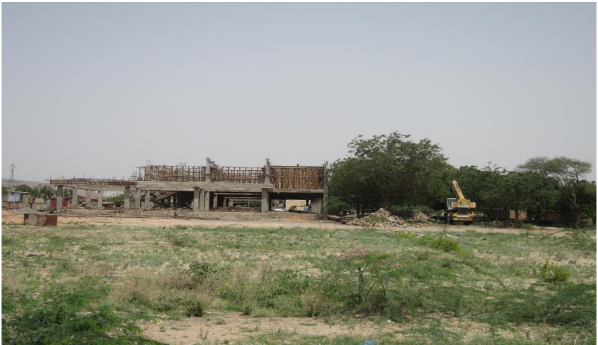
ፎቶ 1: መስከረም 2006 መጠናቀቅ የነበረበት የድሬዳዋ አዲሱ መናኸሪያ ግንባታ ያለበት ደረጃ
