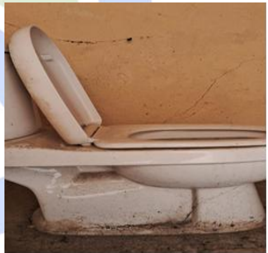
ምስል ቁ. 2፡ በጢያ ዓለም አቀፍ ቅርስ የውሃ አቅርቦት የሌላቸው የመጸዳጃና ሻዎር አገልግሎት መስጫ
