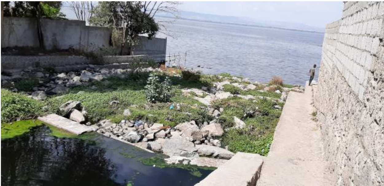
ፎቶ ቁጥር 10. ከሐዋላ ኢንዱስትሪ ፓርክ እስከ ሐዋላ ሐይቅ ድረስ በቀጥታ ተገናኝቶ በተገነባው የዝናብ ፍሳሽ ማስወገጃ (ካናል) አማካኝነት ፍሳሽ ወደ ሐይቁ ሲገባ
