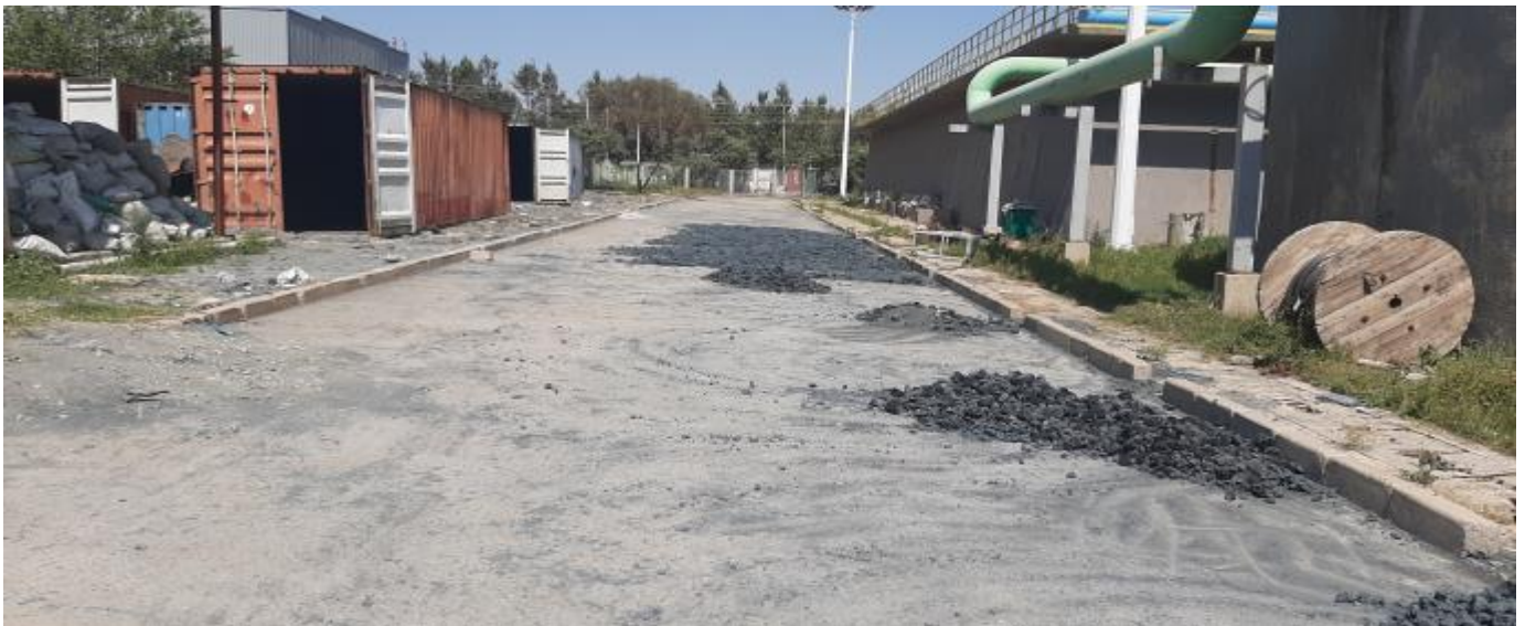
ፎቶ ቁጥር 3. በሐዋሳ ኢንዱስትሪ ፓርክ ዝቃጭ መንገድ ላይ ተበትኖ ሲደርቅ
